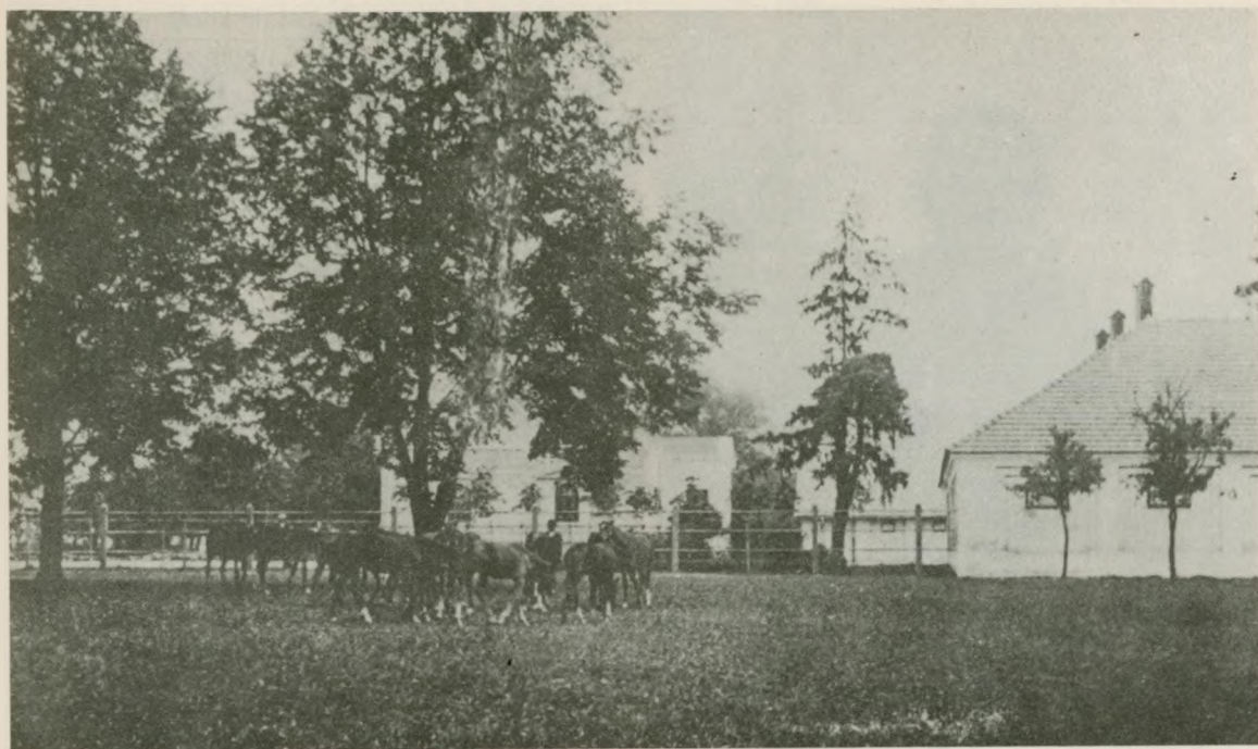
214. Stajnie i paddock w stadninie braci Lubomirskich w Widzowie.
