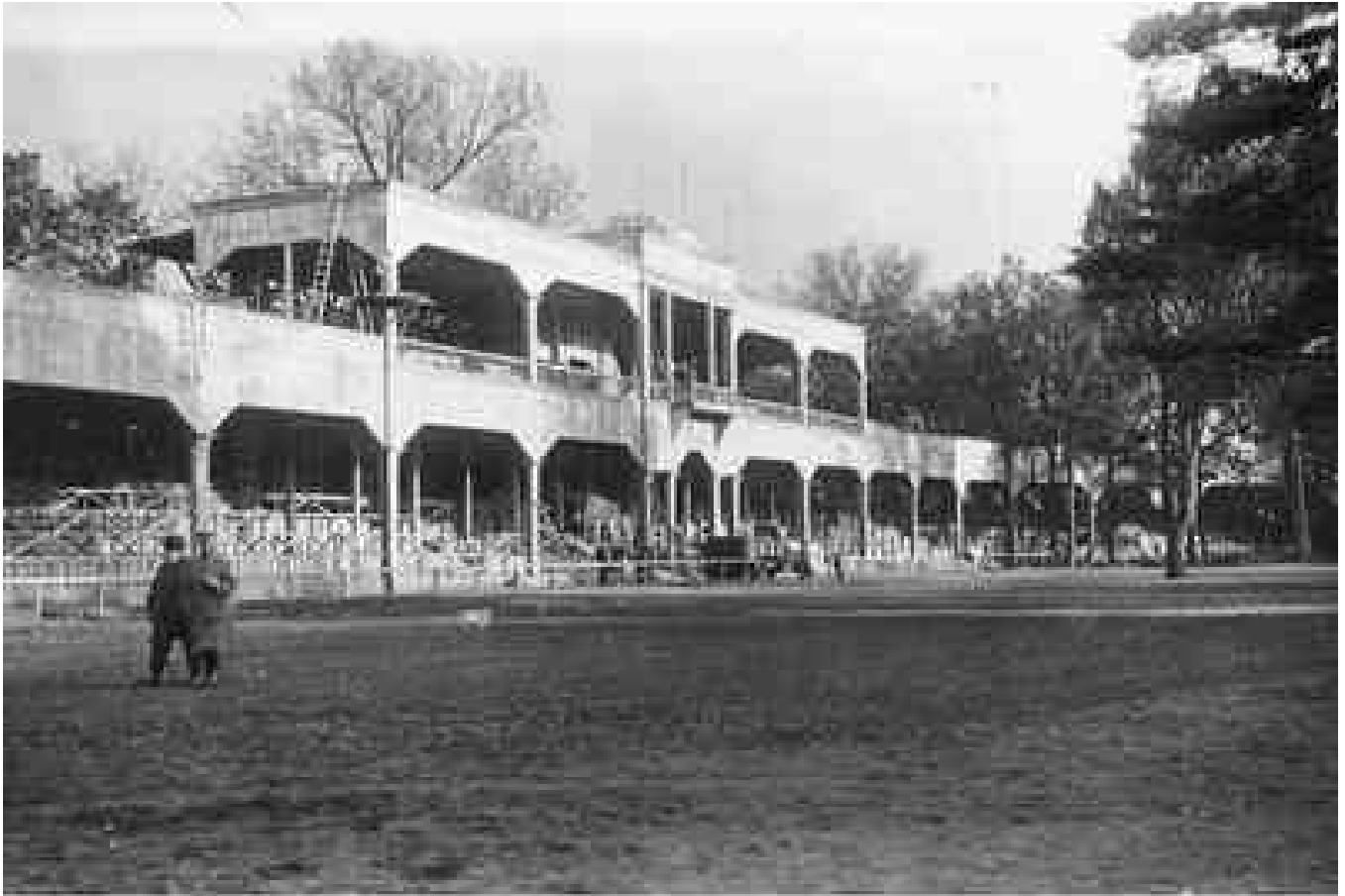
Prace wykończeniowe przy budowie hipodromu w Łazienkach Królewskich w Warszawie (1927). Narodowe Archiwum Cyfrowe.
