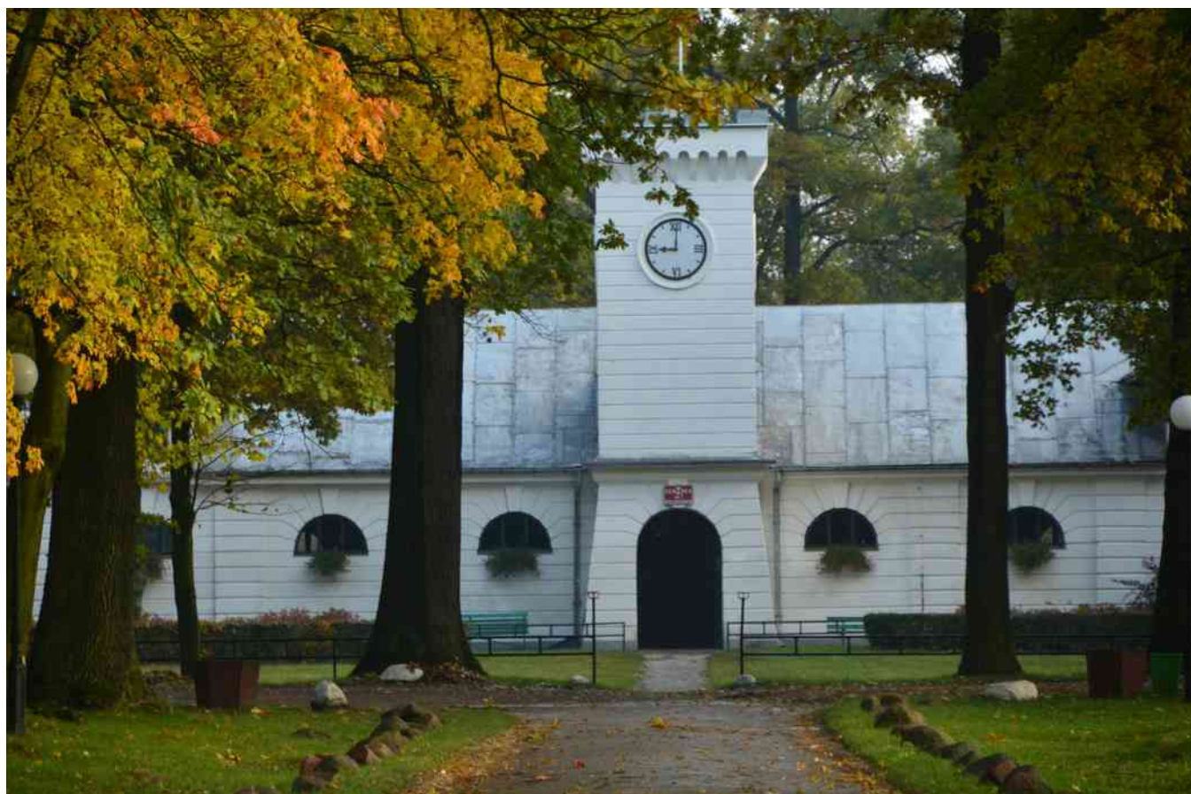
Wieża zegarowa - SK Janów Podlaski, fot. Artur Bieńkowski
