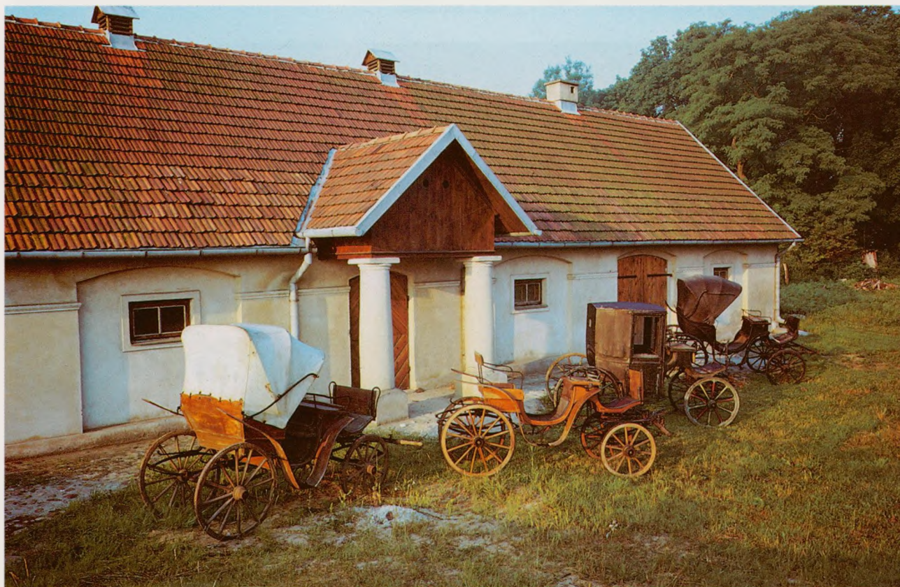
55. Ogólny widok odbudowanej powozowni w Tułowicach.
