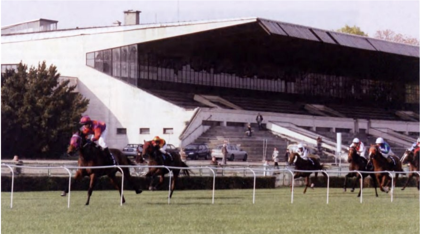
Trybuny Służewca w momencie jego budowy były niezwykle oryginalnym rozwiązaniem architektonicznym.
